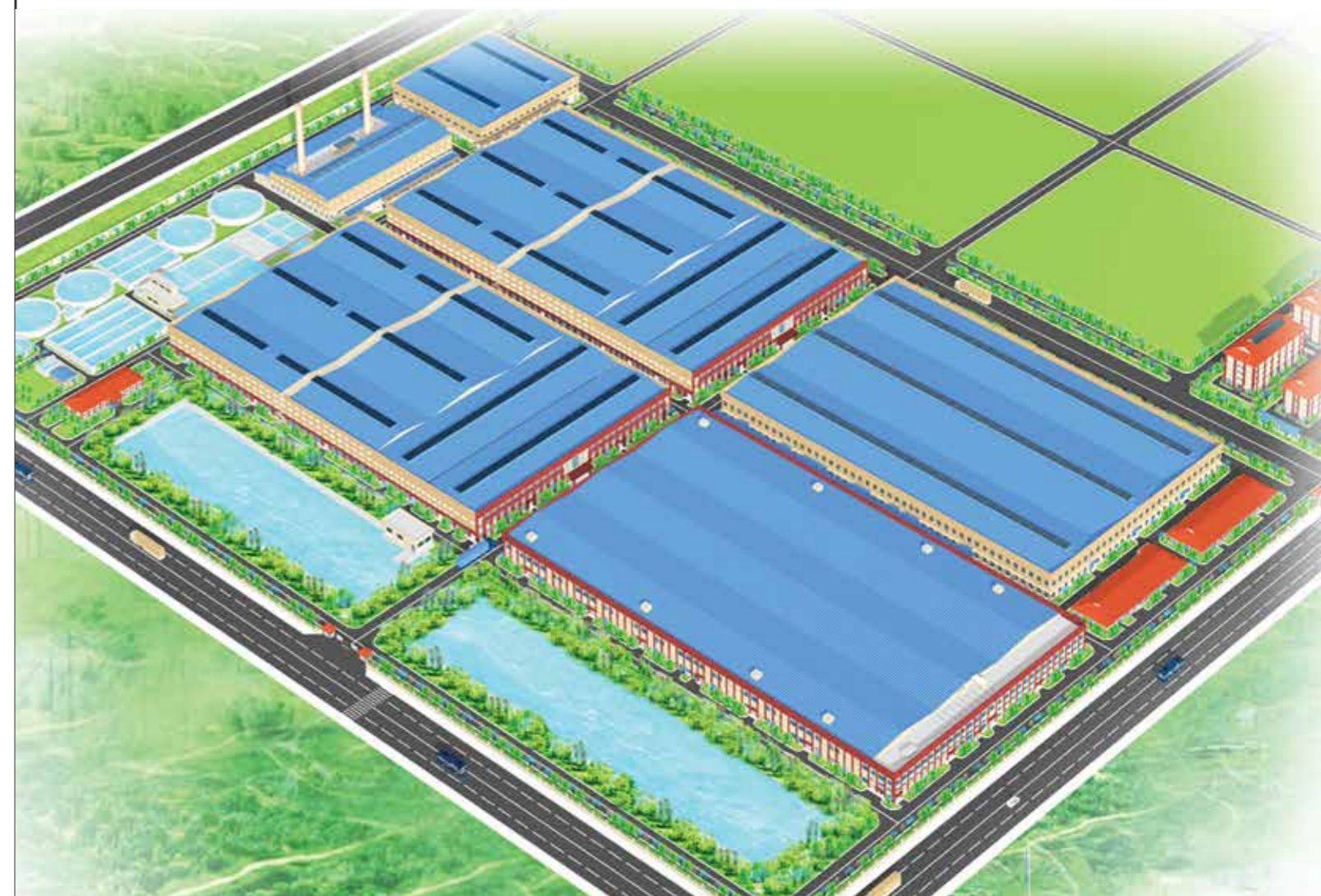
NHÀ MÁY DỆT GAIN LUCKY
